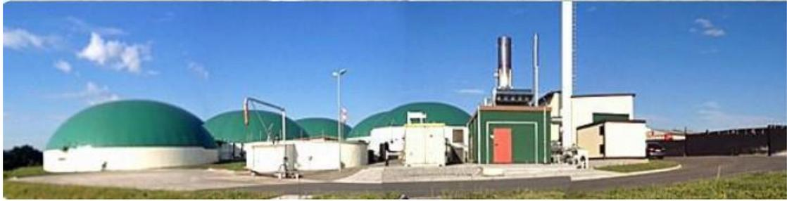
成熟的沼气纯化技术：行业领导者-超过 20 年的沼气纯化经验，全球三分之一市场份额；最成熟可靠的水洗法提纯工艺；交钥匙工程，整套设备完全瑞典生产加工；无需安装单独的脱硫等预处理系统；无需使用任何化学药剂，无需加热，无需核心部件的定期更换；年保障运行时间 97%，甲烷浓度 >98-99%，甲烷损失 <1%；循环水使用降低耗水量，最低运行费用；处理能力范围大；自动化程度高；提供设计、生产、安装、调试、运行、售后服务于一体的服务；安全性极高；通过多家国际权威第三方机构验证；适应中国市场-中国项目实例，免去新进口设备重新设计调整。
