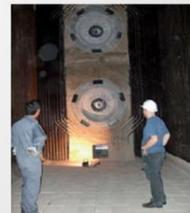
低氮燃烧器+烟气再循环（FGR）+空气分级（BOOS、OFA）组合工艺
